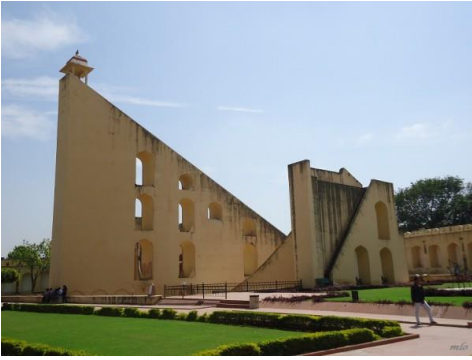
N° 17 : Vue des graduations. L'ombre projetée permet de connaître l'heure exacte sur les marques incrustées de l'échelle incurvée.
