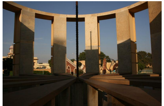
N° 14 : Le Rama Yantra . Il est horizontal et sert à déterminer l'altitude et l'azimut des planètes par lecture des graduations figurant sur les murs et le pavement de deux constructions circulaires (photo de droite).
